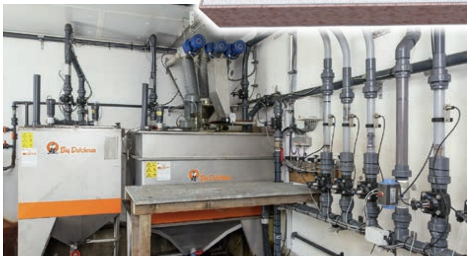
Blanderum: 1-tank anlæg med brugtvandstank og 4 JET-stik
