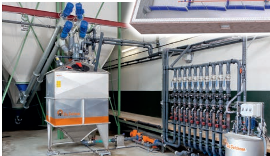
Blanderum: 1-tank anlæg med fyldte stik til en slagtesvinestald med 2000 stipladser
